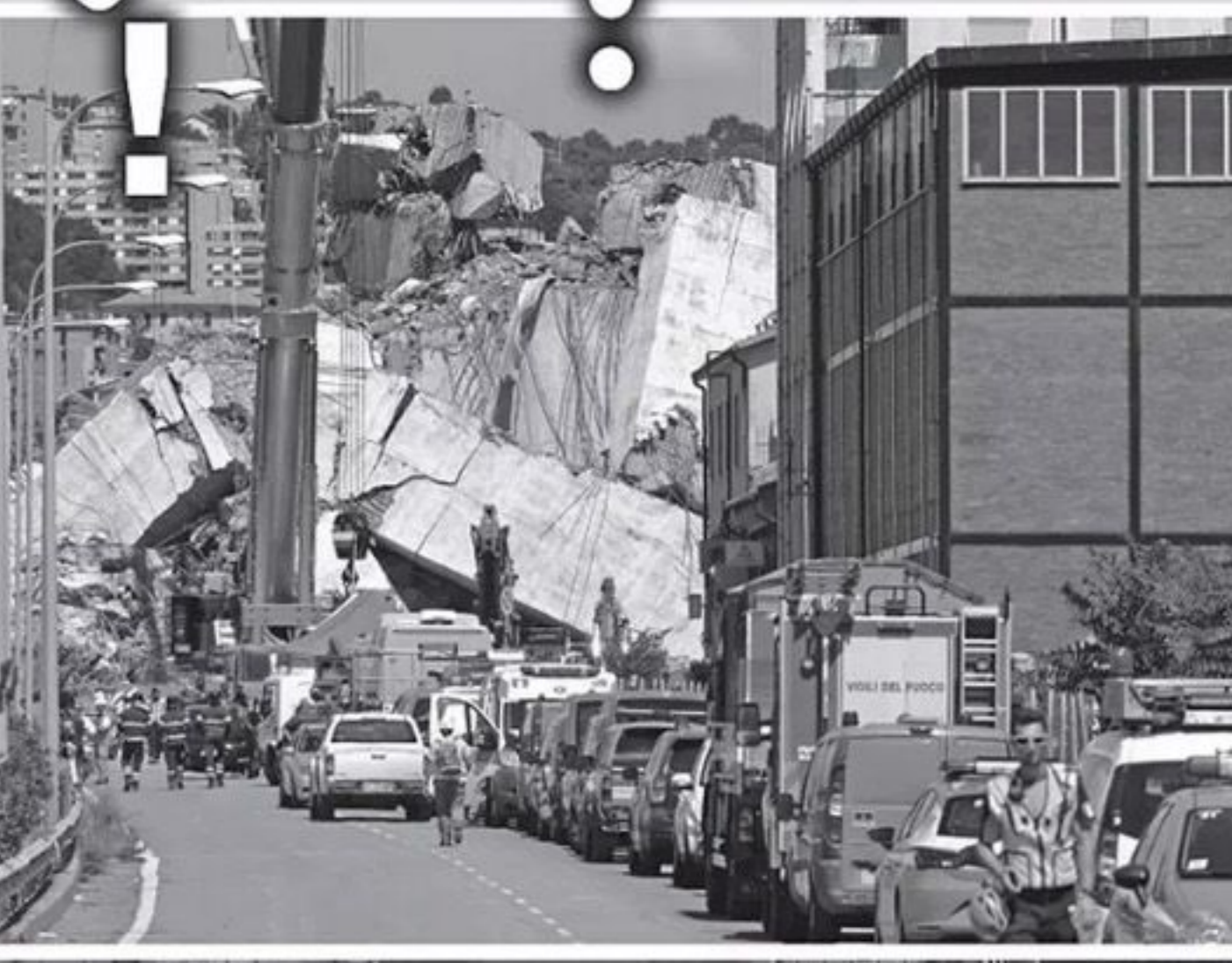
モランディ橋の事故では8月24日までに43名の死亡が確認された。今後、主塔が倒壊する危険があり、近隣住民が避難する事態に
